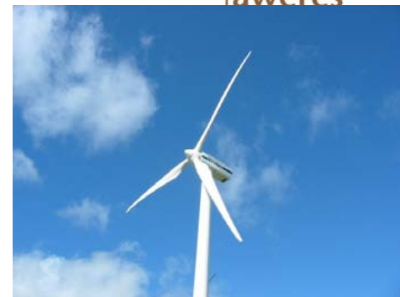
Vestas 1650 kW , promjer rotora od 63metra.
